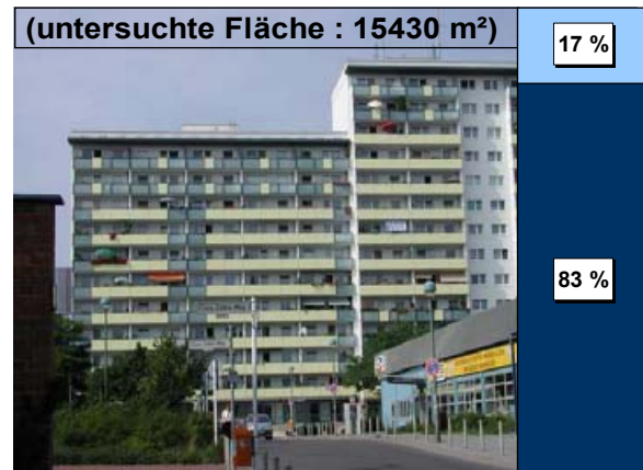
11- und 14-Geschosser Einrohrheizung
