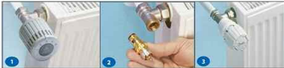
1 Alten Fühler demontieren
