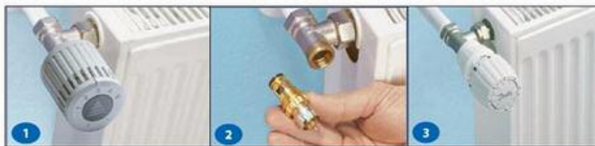
1 Alten Fühler demontieren
