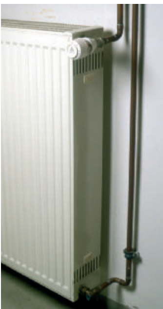
■ An den mit Danfoss-RAVL-Ventilen ausgestatteten Heizkörpern wurden die alten, nicht voreinstellbaren Ventileinsätze gegen neue mit Voreinstellung ausgetauscht und moderne Fühler nachgerüstet.
