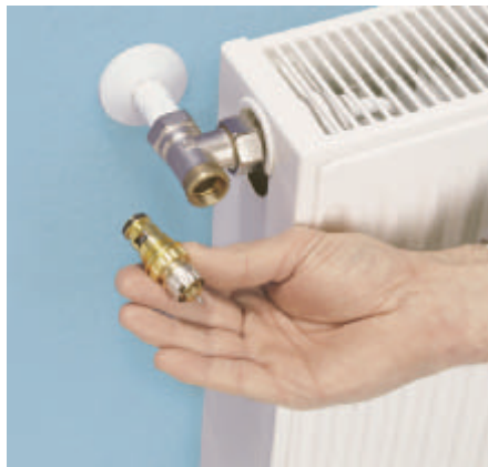
■ Die Umrüstung eines alten Thermostatventils ist schnell gemacht. Dazu wird der alte, nicht voreinstellbare Ventileinsatz mit wenigen Handgriffen gegen einen voreinstellbaren ausgetauscht. Zum Lieferumfang gehört ein Thermostatkopf.
